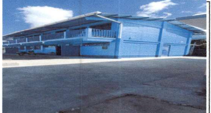
Foto 4: REPARACION DE PINTURAS EN MUROS EXTERIORES.
