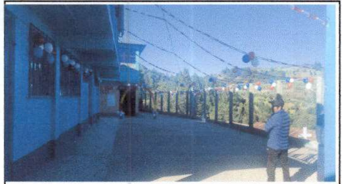
Foto 2: SUSTITUCION DE PISO DE TORTA DE CONCRETO
