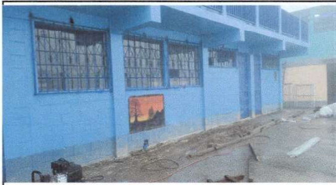
Foto1: SUSTITUCION DE BALCONES
