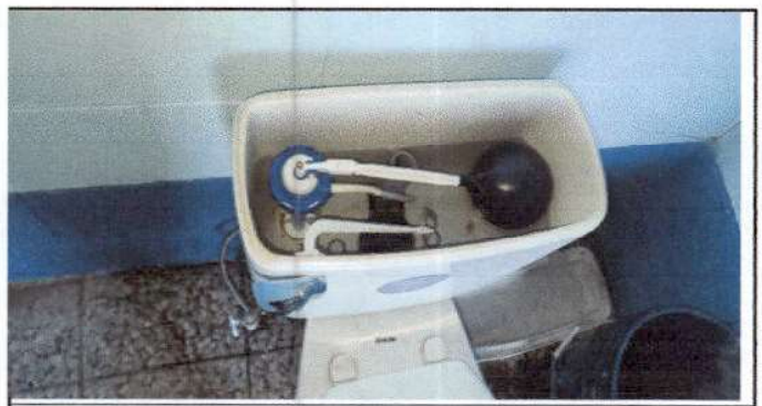
Foto 6: SERVICIOS SANITARIOS Y SUS ACCESORIOS
