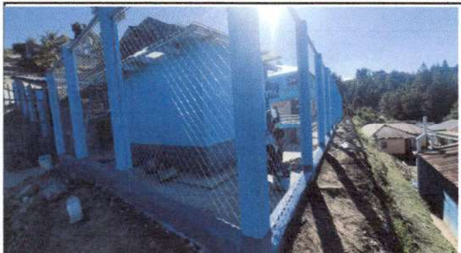
Foto 3: REPARACION DE MUROS PERIMETRALES
